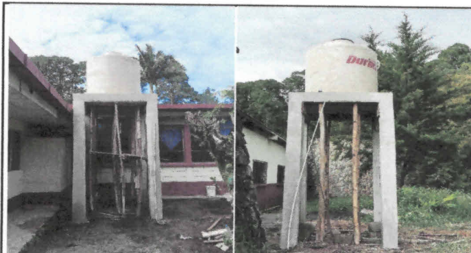
Foto 3: Colocación de base de concreto para tinacos, útiles para la distribución de agua en los servicios sanitarios.
