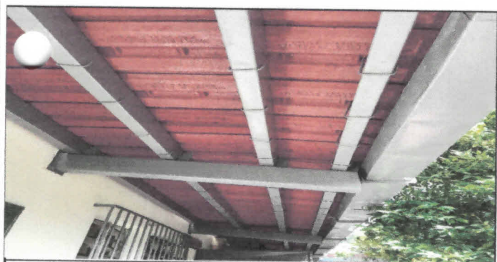
Foto 5: Cambio de techo de teja, fue necesario el cambio por el deterioro que presentaba.
