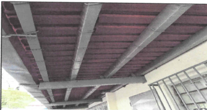
Foto 4: Cambio del techo de teja, exterior de biblioteca, es necesario porque la teja estaba deteriorada.
